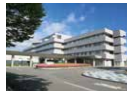
国際医療福祉大学塩谷病院(栃木県矢板市)
